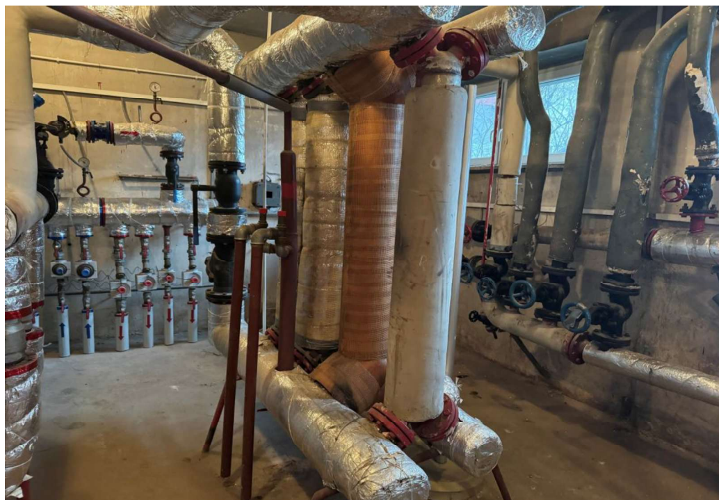
Źródło ciepła dla budynku - węzeł ciepłowniczy dla c.o..
