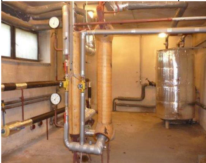
Widok ogólny węzła ciepłowniczego ( z lewej cwu z prawej co).
