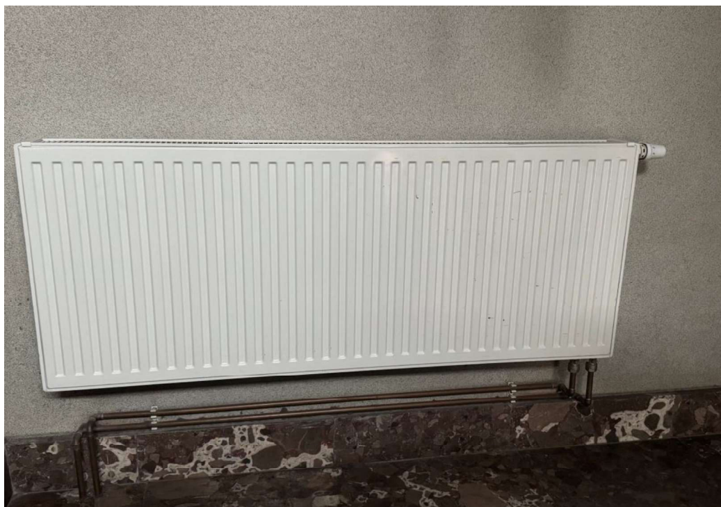
Grzejnik stalowy płytowy z zaworem termostatycznym i głowicą.
